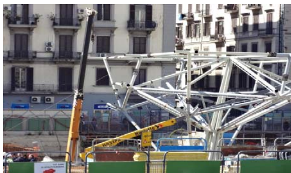
Fig. 5: Cantiere piazza Garibaldi
